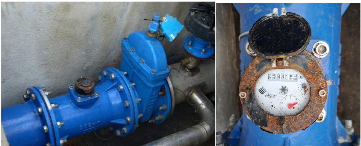
Foto 28. Contador na saída do depósito da ETAP de Condide
