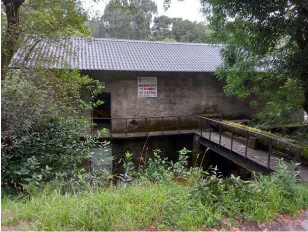
Foto 6. Estación de Bombeo de A Barca
