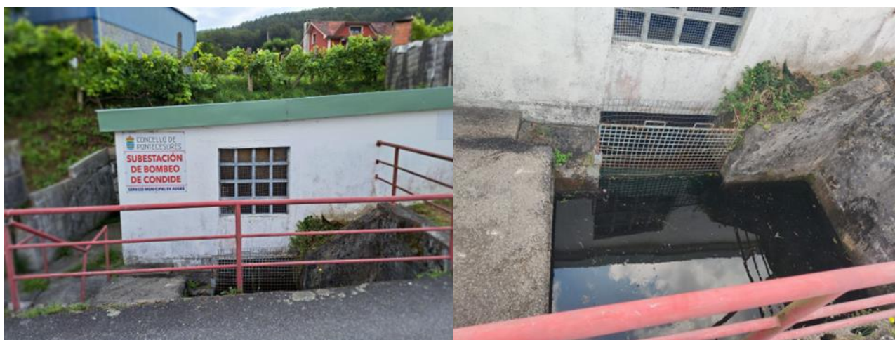
Foto 17. Estación de Bombeo de Condide
