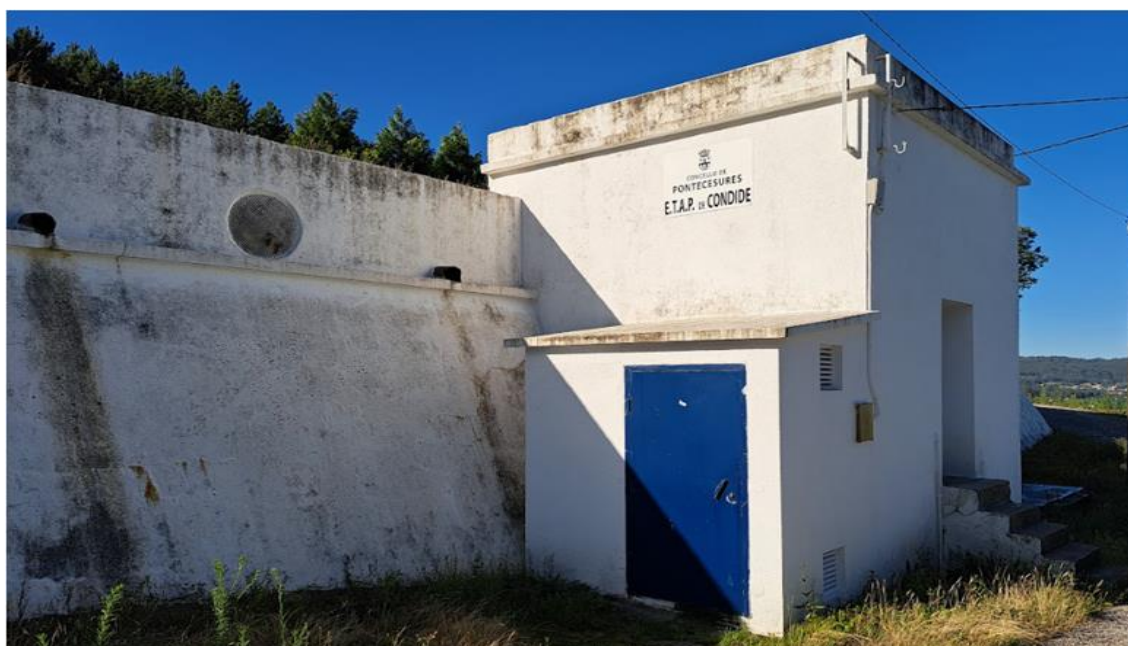
Foto 25. Depósito da ETAP de Condide
