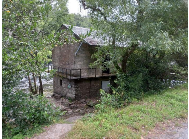
Foto 7.. Estación de Bombeo de A Barca
